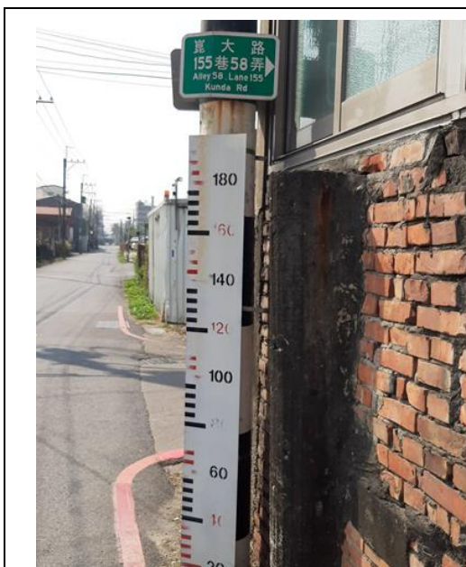
崑山科 大圍牆 邊智慧 水尺
