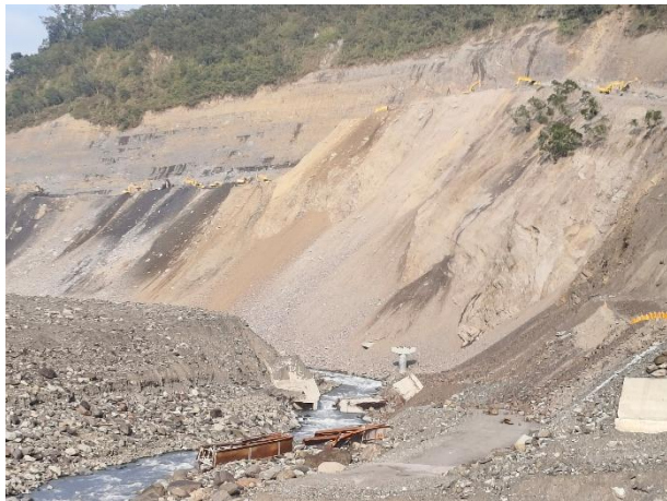
山腰施工處為歐帕克爾臺，是古玉穗溪的土石流堆積而成，目前工程單位正趕工修建新台 20 線公路。
