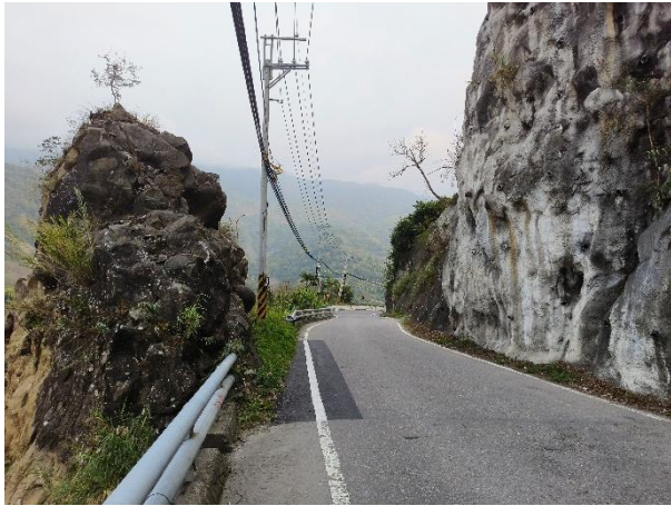
馬路右側枕熔岩狀因安全考量，已被灌上水泥及排水設計。
