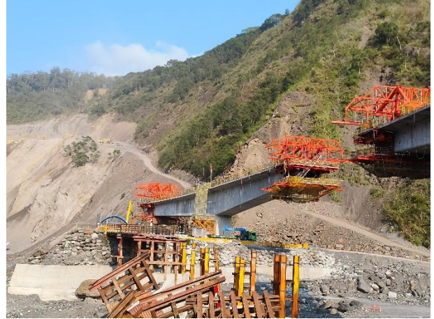
新建橋梁興建趕工中，下方為明壩克露 橋便橋 2024 年遭凱米颱風洪水土石流 沖毀。
