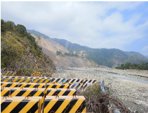
舊寶來一橋功成身退，舊橋已成歷史，新橋通車後現已拆除。
