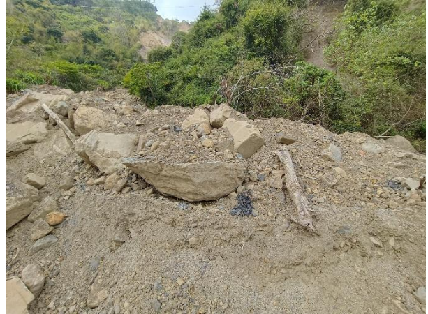
堆積的土石中發現有大砂岩塊及上層表土風化層或崩積土。
