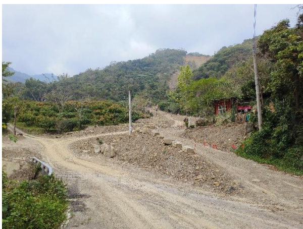
打鐵坑溪左岸小溪流還遺留去年的土石流遺跡，周圍尚有三戶住家。
