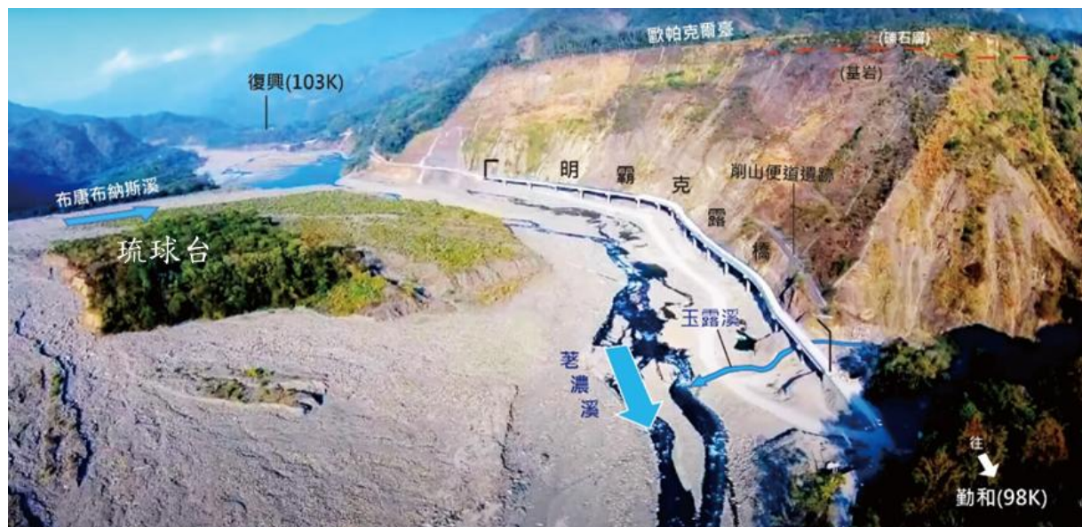
明霸克露橋(2017)位於三溪交會處，荖濃溪和其二條支流(布唐布納斯溪和玉穗溪)。
