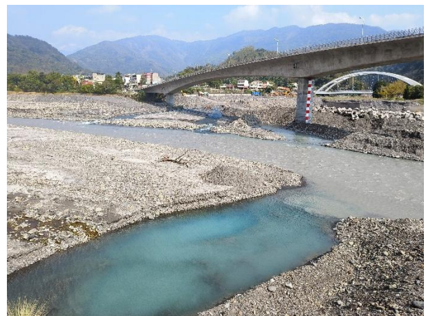
荖濃溪右岸小溪流於新寶來一橋與荖濃溪主水流匯集處，發現清澈與混濁的兩個水系。
