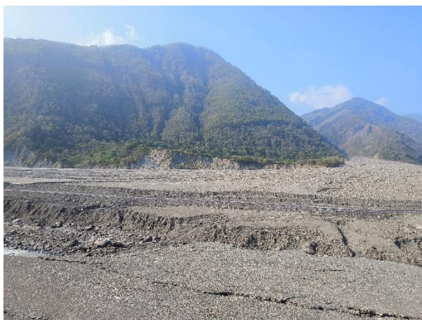
布唐布那斯溪的土石流形成一開闊的沖積扇，造成曲流河水衝擊明壩克露橋。
