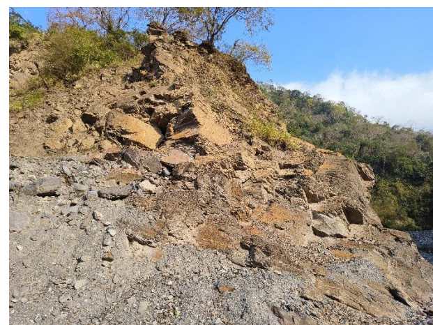
越上層的岩層風化越嚴重，並有明顯的 岩層斷裂情形。
