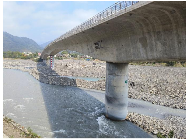
新寶來一橋改為拱形加高方式興建，以防汛期的強大洪水。。
